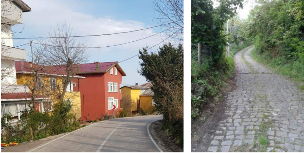
Resim 26-27: Çınar Mahallesi Ana Yol: URL-6: Perşembe Belediyesi.
