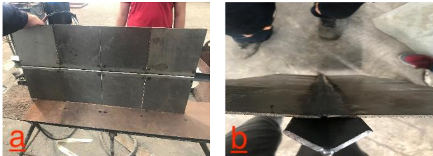
Şekil 4. a. Levhaların puntalanması, b. Levhaların birbirlerine çatılması.
