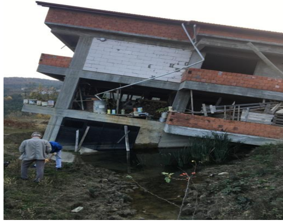
Fotoğraf 3. Devrek-2 Numunesinin Alındığı Etek Bölgesinde Zemine Gömülmüş Bir Ev 2.3. Devrek-3 Numunesinin XRD Yöntemi ile Bulunan Bileşimi ve Özellikleri
